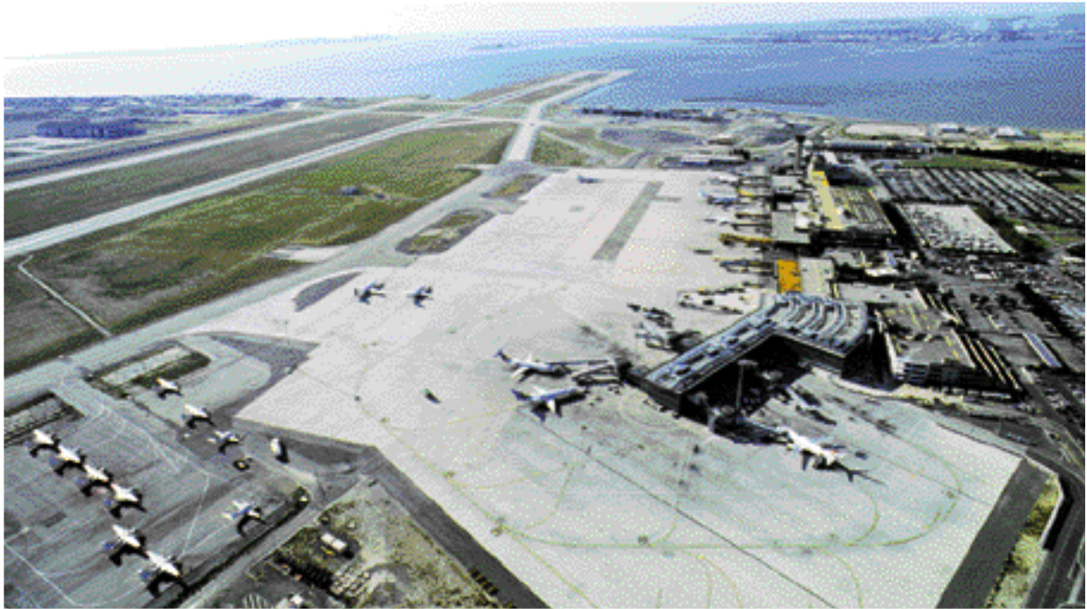
Aéroport de Marseille Provence - Vue générale des chaussées aéronautiques
