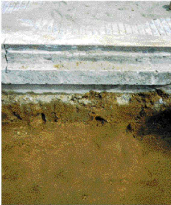
Sondage mettant en évidence les différentes couches de matériaux
