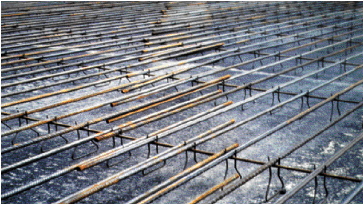
Béton armé continu - Recouvrement des aciers longitudinaux
