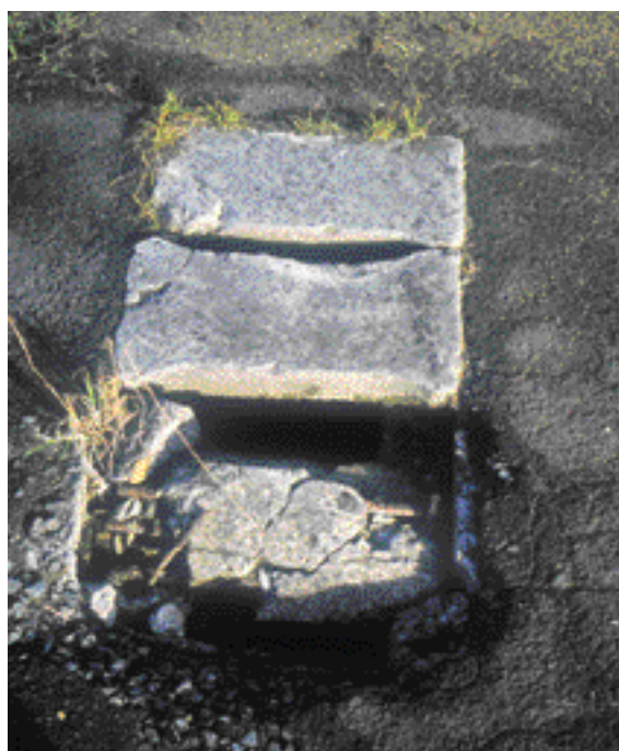
Image inacceptable d'un défaut de suivi du réseau d'assainissement
