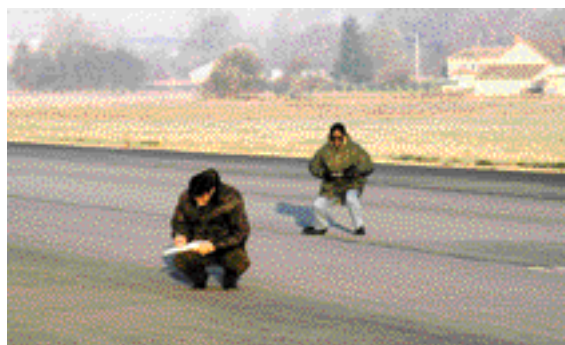
Techniciens effectuant un relevé visuel de dégradations
