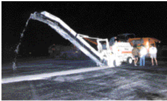
Fraisage d'une ancienne chaussée souple
